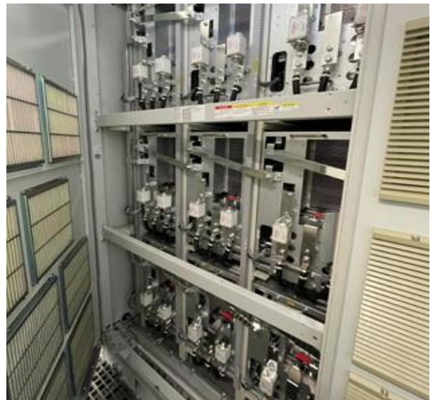
Die Antriebseinheiten bilden das Herzstück und den Leistungsteil des Wechselrichters. Bei Bedarf können sie modular herausgezogen und gewartet werden. Quelle: Mitsubishi Electric Europe B.V.
